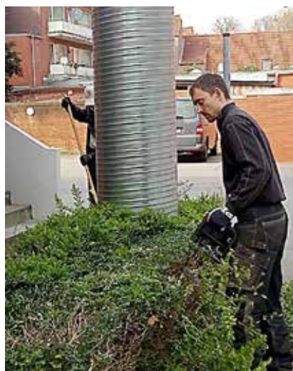
Andre Lambertsen studser hækplanterne ved Husumhus' ventilationscentral. (Fotos: Peter Hansen)
