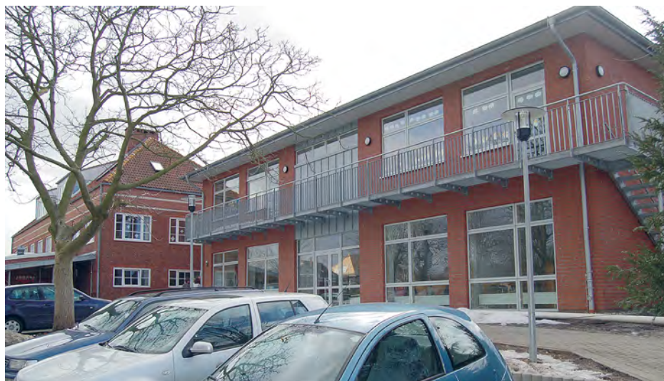
Bredsted Danske Skoles flotte tilbygning - med bl.a. et forenings- og kirkelokale. (Foto: SPT)
