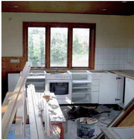
Det nye køkken er ved at blive opsat i Kongens Hus. (Foto: FDF)
