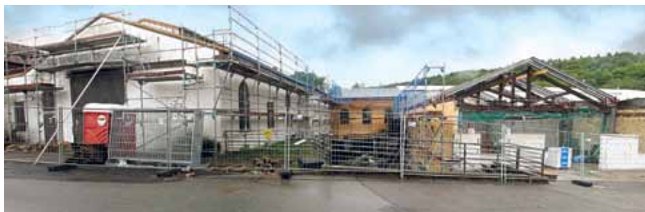
Har man med gammelt byggeri at gøre, skal der som regel pilles ned, inden man kan bygge nyt. Sålledes også i Kobbermølle: Hallerne, da de så værst ud. (Foto: privat)
