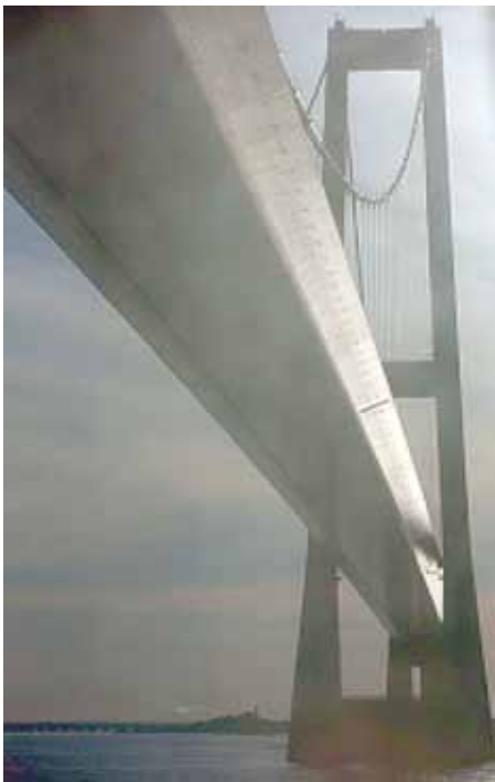
Fra undersiden er Storebæltsbroen endnu mere imponerende end set fra oven.
